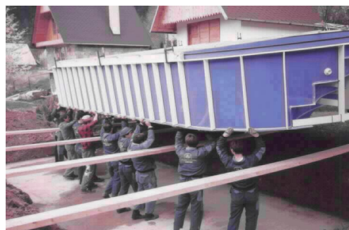
Obr. Prekládka bazénu pomocou pracovníkov
