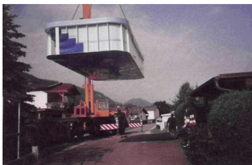
Obr. Prekládka bazénu pomocou žeriavu
